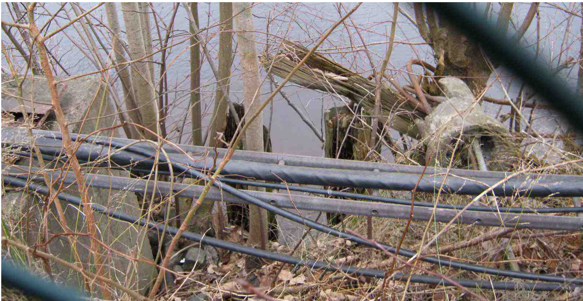
Figur B.1.10 Fotografi tagen vid Järnvägsbron sydlig riktning över träskoning vid Sävåns norra sida (Delområde B).
