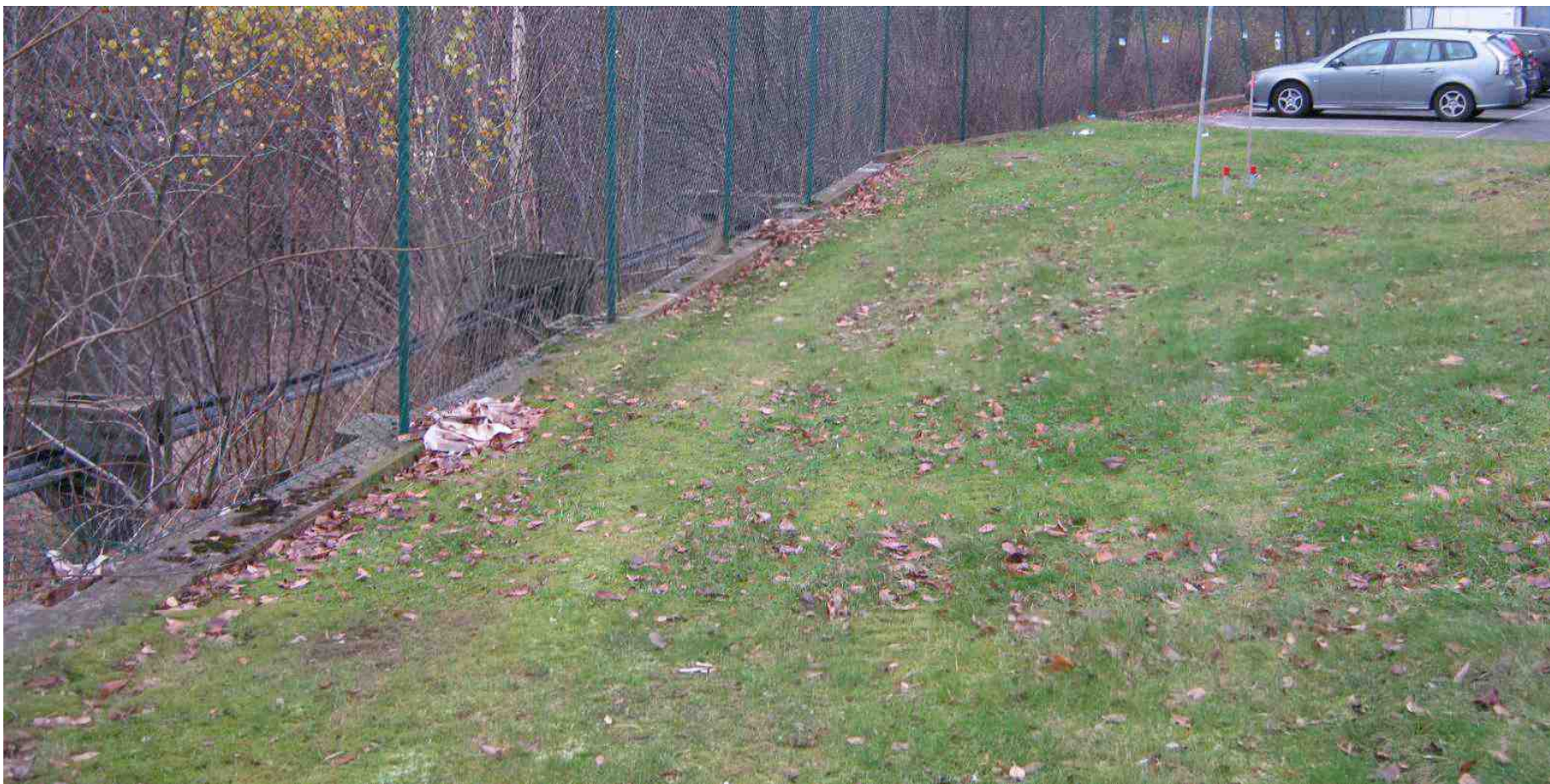
Figur B.1.8 Fotografi tagen vid Järnvägsbron västlig riktning över stödmur vid Sävåns norra sida (Delområde B).
