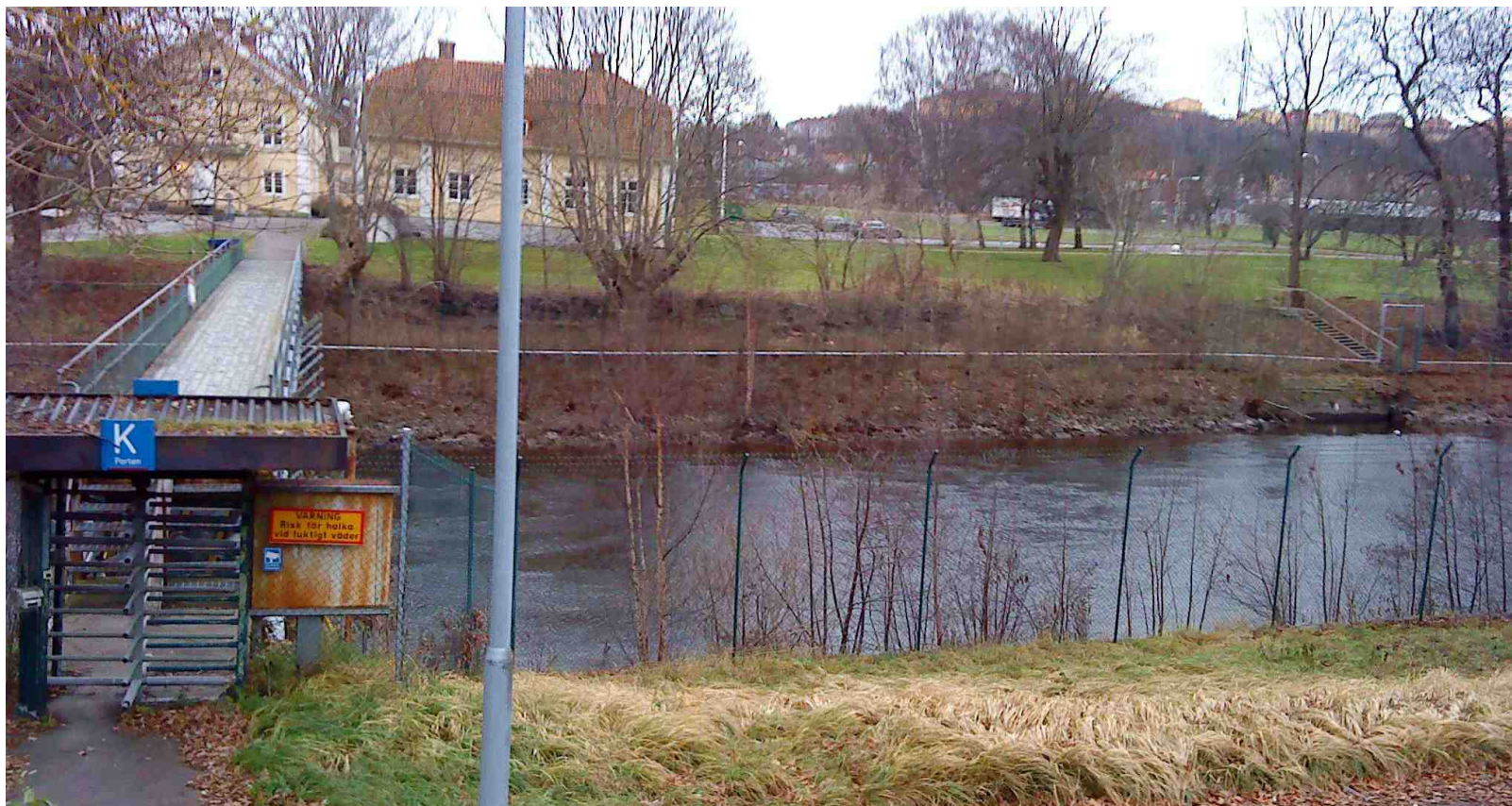
Figur B.1.20 Fotografi tagen vid Ryttmästarebron sydlig riktning över erosionsskydd vid Sävåns södra sida (Delområde F).
