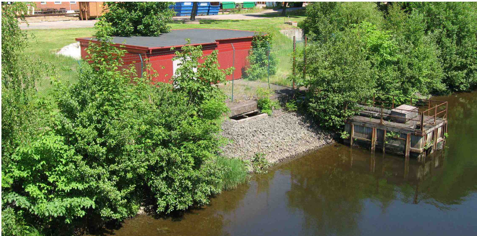
Figur B.1.12 Fotografi tagen från Järnvägsbron nordöstlig riktning över erosionsskydd vid Säveåns norra sida (Delområde C).
