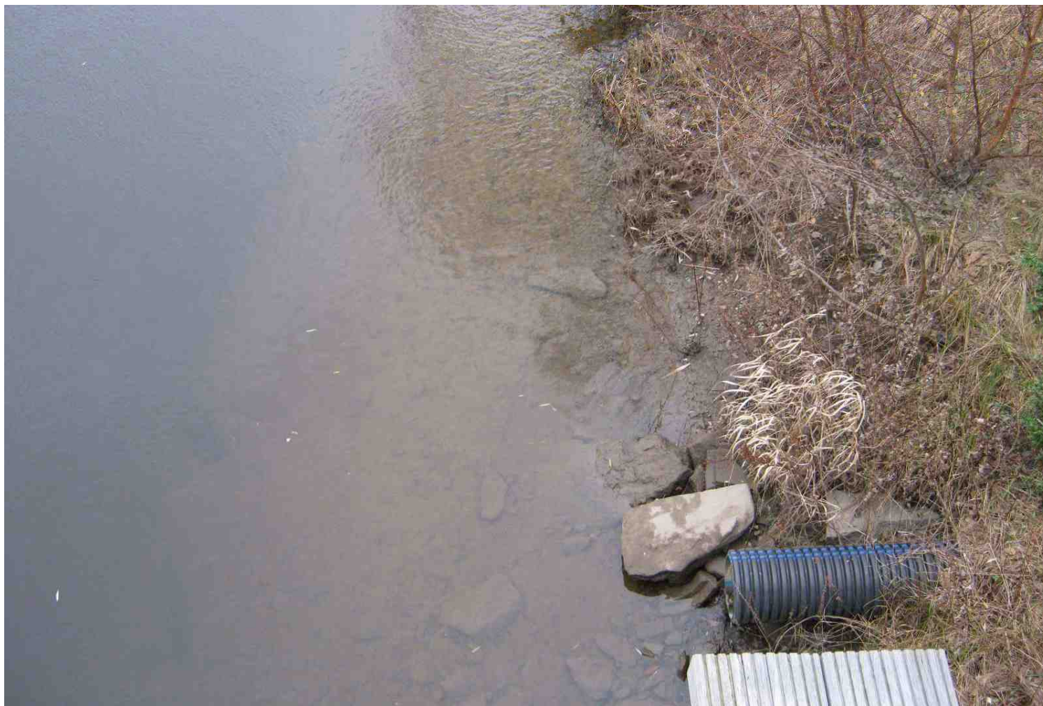
Figur B.1.5 Fotografi tagen från Sjukstugebron i västlig riktning över erosionsskyddet vid Säveåns norra sida (Delområde A).
