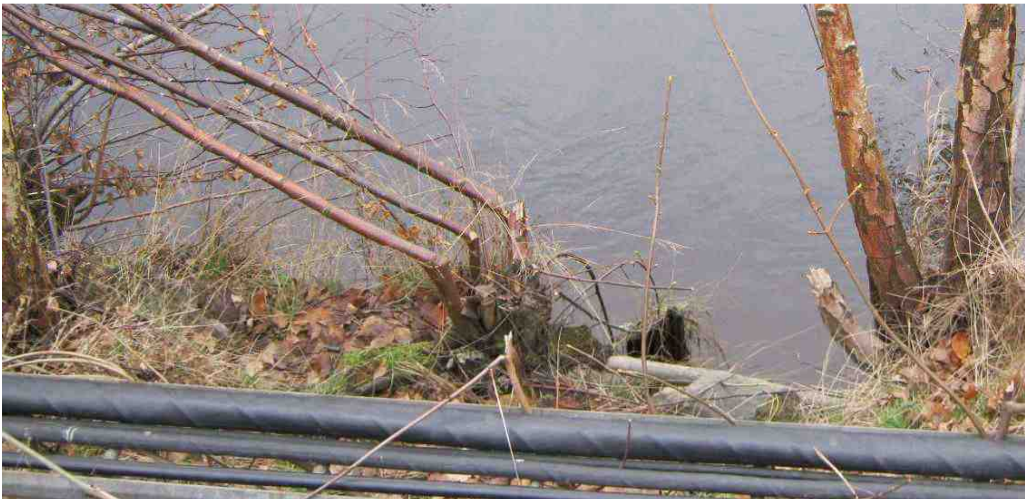
Figur B.1.9 Fotografi tagen vid Järnvägsbron sydlig riktning över träskoning vid Sävåns norra sida (Delområde B).
